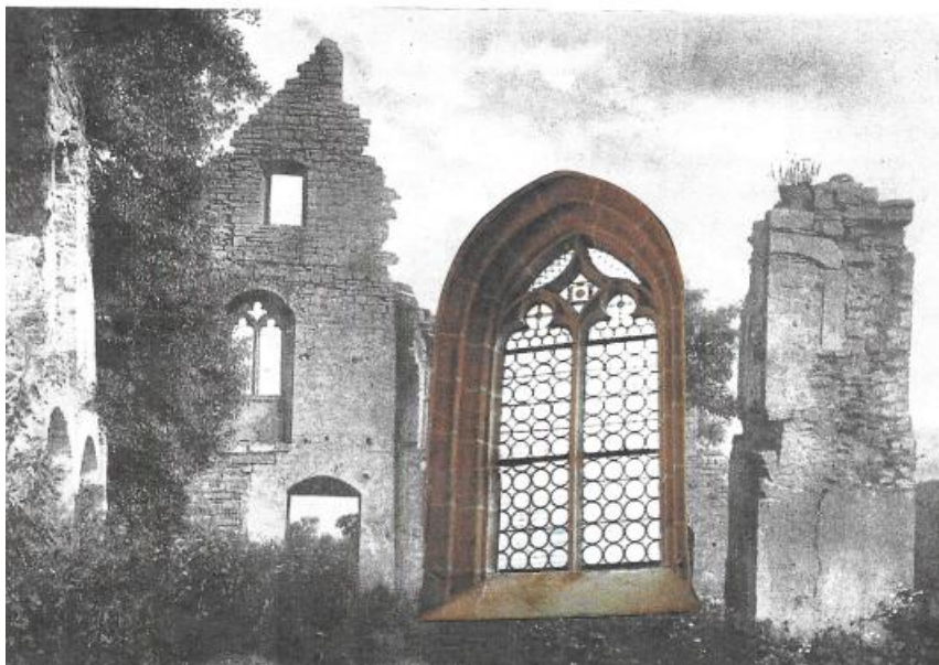
Teilausschnitt des Fotos von 1913 mit dem gotischen Fensterwerk und Darstellung eines gotischen Maßfensterwerks mit schlichten Butzenscheiben.
